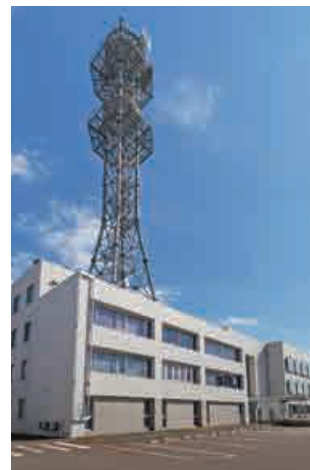
新潟国道事務所 外観
