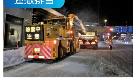
路肩にたまった雪を雪捨て場へ運び出します。
