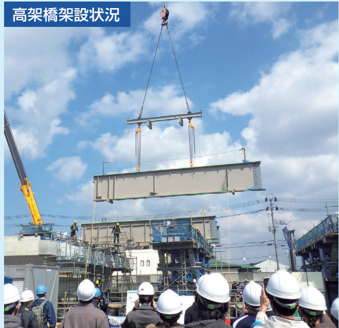
橋脚間に橋桁を支える仮設の支柱を組み立て、現場に輸送された部材をクレーンで架設し、橋桁として連結します
