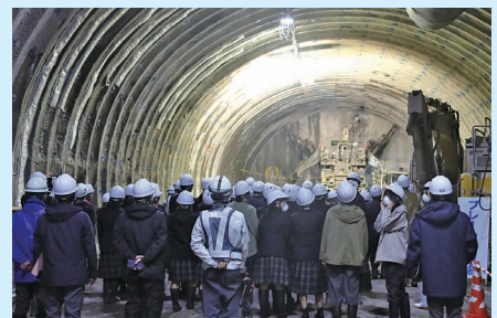
工事中の(仮称)2号トンネルを見学
