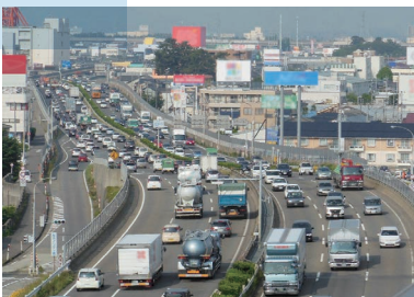
■新潟国道管内における交通量ランキング (令和3年度の平日昼間12時間)
