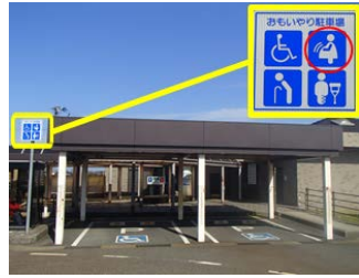
屋根付き駐車スペース
