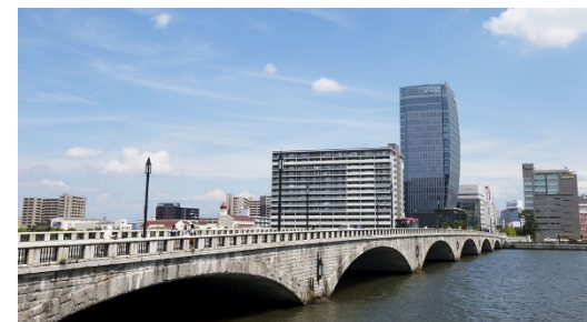
三代目萬代橋(昭和4年8月～現在) 橋長/306.9m(新潟地震前約309m)、幅員/22.0m
