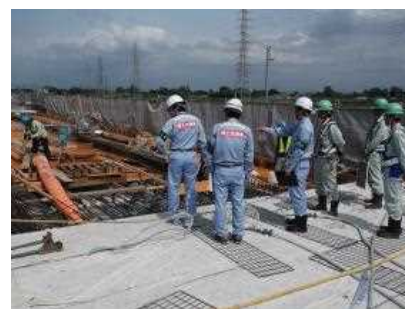
工事安全パトロールの様子
