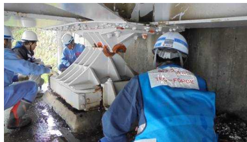
橋梁損傷状況調査
