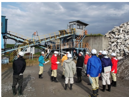
コンクリートガラの処理施設
