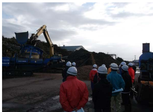
樹木系廃棄物の処理施設
