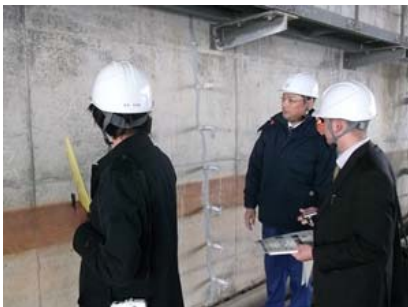
ひび割れ注入工法を説明
