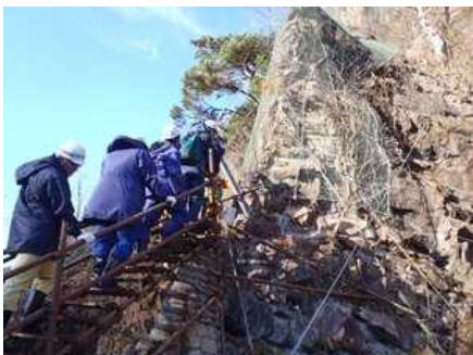
防災点検の状況
