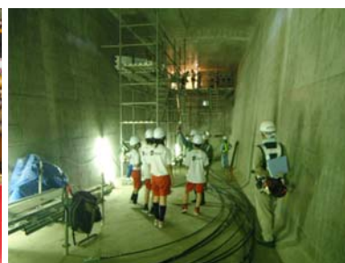
揚川改良 橋の中を見学
