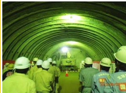
トンネル貫通の瞬間
