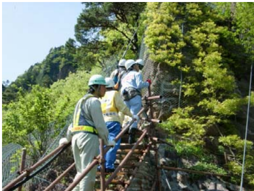
防災点検の状況
