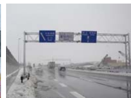
オフランプ分岐部
