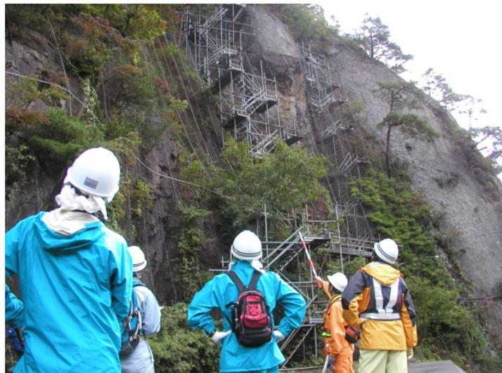
点検の結果、岩盤斜面の変状や落石防止網等の施設の異常は発見されませんでした。
