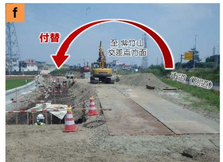
新たに紫竹山ICのランプを設置する場所にある市道(側道)の付替工事を行っています。
