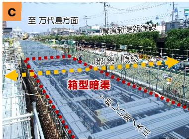
新しい栗ノ木川の上に道路(網川原線)を通すため、地中にコンクリートの箱(箱型暗渠)をつくっています。
