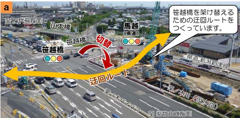
笹越橋の架け替えに向けて、笹越橋・馬越(県道)の両交差点を紫竹山IC側に迂回させるための工事を行っています。
