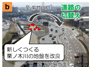
栗ノ木バイパスを西側に切替え、地盤改良を行いました。
