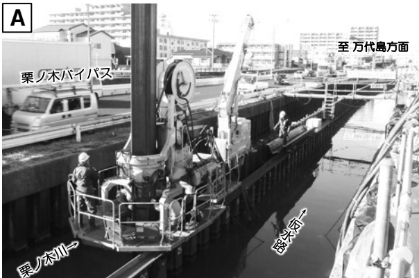
栗ノ木川の仮水路を設置するため、鋼矢板を打設しています (H27.12.9撮影)
