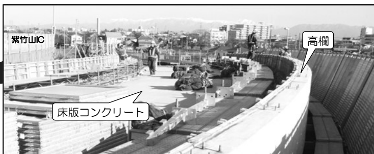
床版コンクリートを打設しました (H27.12.9撮影)
