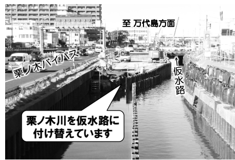
栗ノ木川仮水路施工状況 (H27.11.4撮影)
