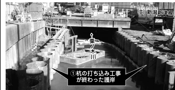
笹越橋下流部の栗ノ木川付替工事の状況(11月21日撮影)
