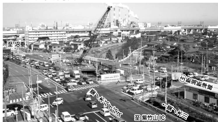
■工事進捗状況写真(11月28日撮影)
