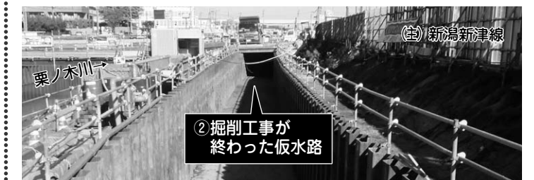
笹越橋上流部の仮水路掘削工事の状況(11月21日撮影)
