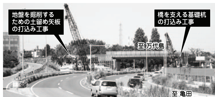
紫竹山IC改良工事の状況(7月21日撮影)
