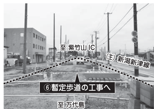
(主)新潟新津線の付替工事の状況 (9月25日撮影)
