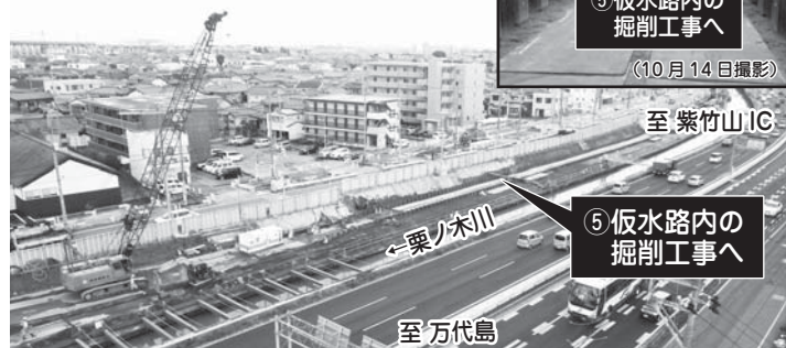
笹越橋上流部の栗ノ木川付替工事の状況 (9月30日撮影)
