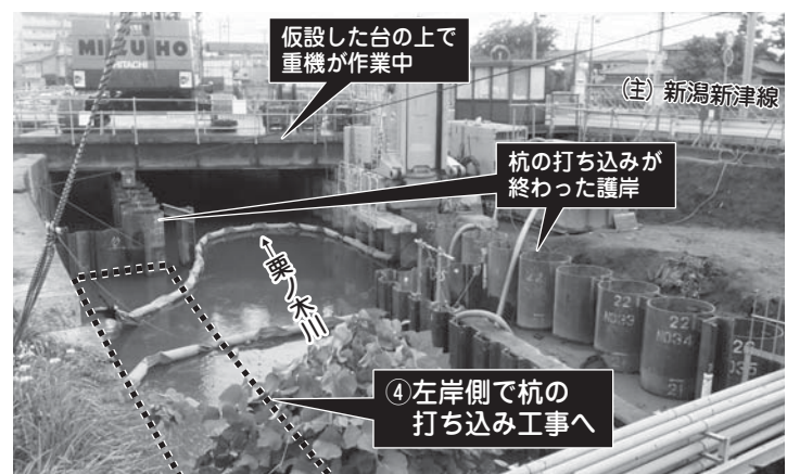
笹越橋下流部の栗ノ木川付替工事の状況 (10月27日撮影)
