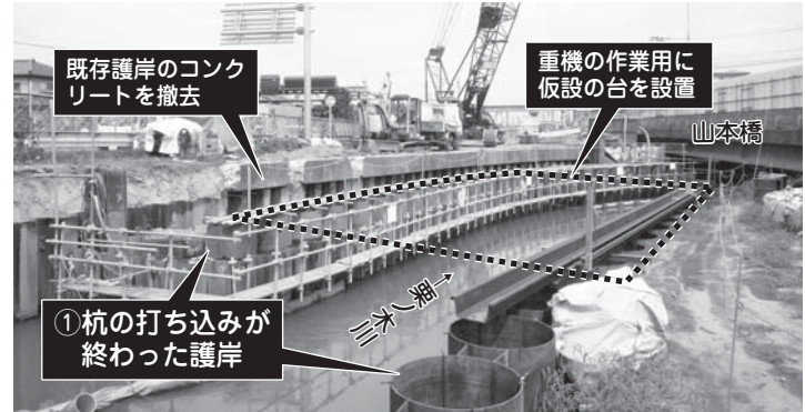
笹越橋下流部の栗ノ木川付替工事の状況 (8月19日撮影)
