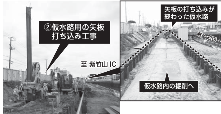
笹越橋上流部の栗ノ木川付替工事の状況 (8月19日撮影)
