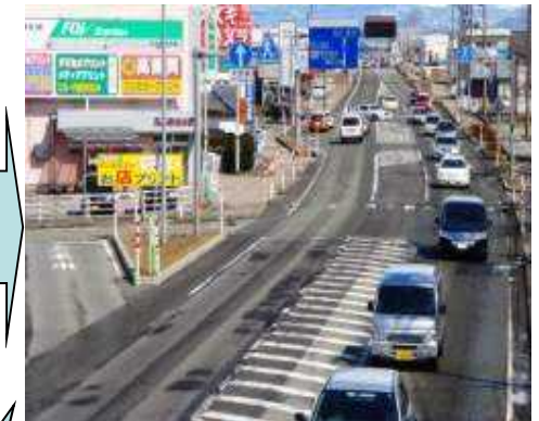
大型車の減少傾向が見られ、渋滞が 緩和した村上市街地(国道7号)
