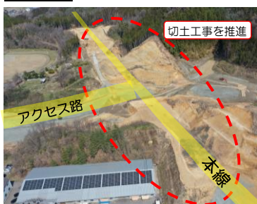
写真③ 府屋地区の長大切土
