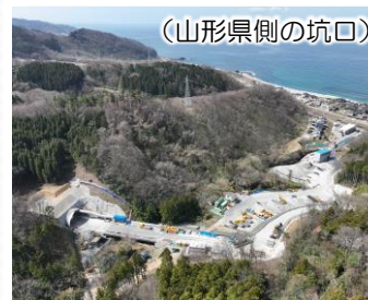
11号トンネル工事現場全景
