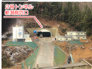
写真① 2号トンネル
