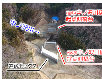
写真④ (仮称)中ノ沢川橋
