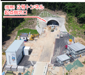
写真② (仮称) 2号トンネル
