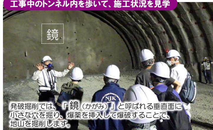
発破掘削では、「鏡（かがみ）」と呼ばれる垂直面に小さな穴を掘り、爆薬を挿入して爆破することで、地山を掘削します。
