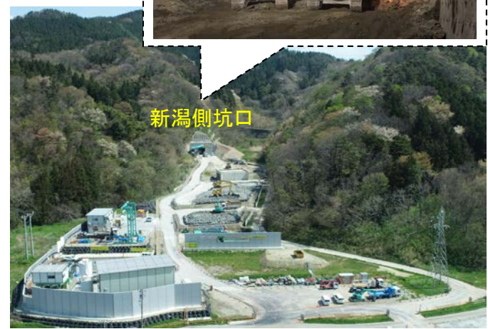
(仮称)11号トンネル工事現場全景
