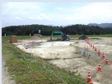
7月より農道ボックスの工事に着手し、現在掘削作業中
