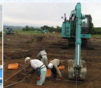
準備工の状況 (重機と人力による表土剥ぎ)
