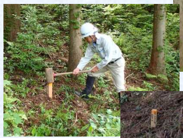
幅杭(朝日地区)
