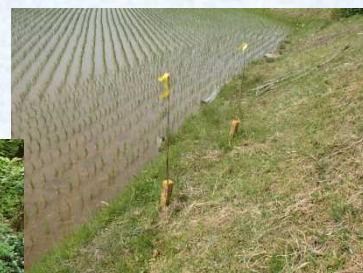
仮幅杭※(山北地区)
