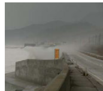
国道7号越波状況（府屋地区）
