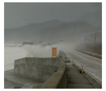
国道7号越波状況 (府屋地区)
