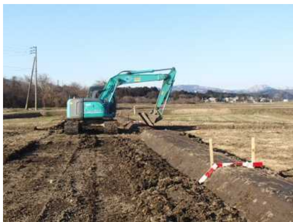
畦畔設置状況
