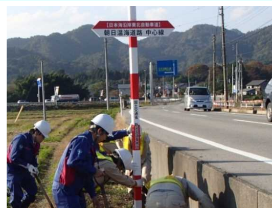
路線標識の設置
