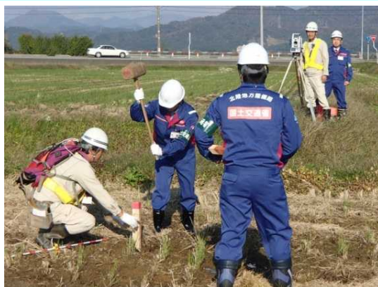
中心杭の設置
