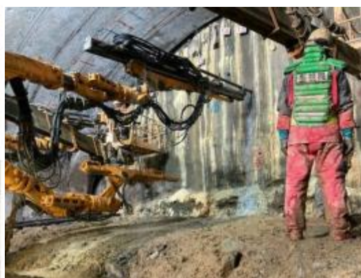
脆弱な地山における切羽安定対策 (11号トンネル)
