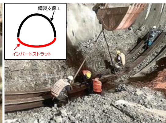
トンネル断面変状の対策実施状況 (鼠ヶ関トンネル)
