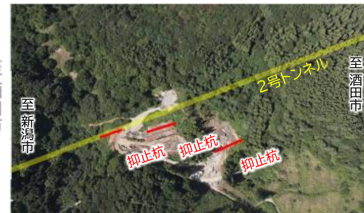
抑止杭施工箇所
