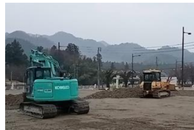
施工状況(路床盛土)
