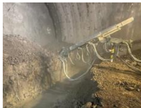
インパート吹付の施工例
