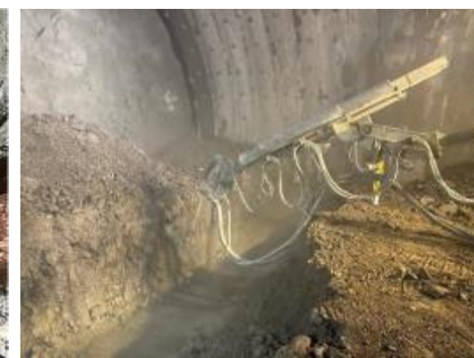
トンネル断面変状の対策実施状況 (小岩川第2トンネル)
