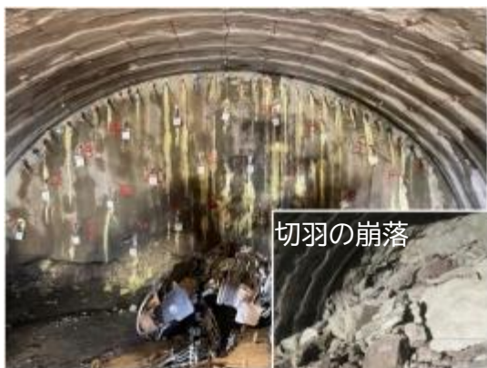
脆弱な地山における切羽安定対策 (2号トンネル)
