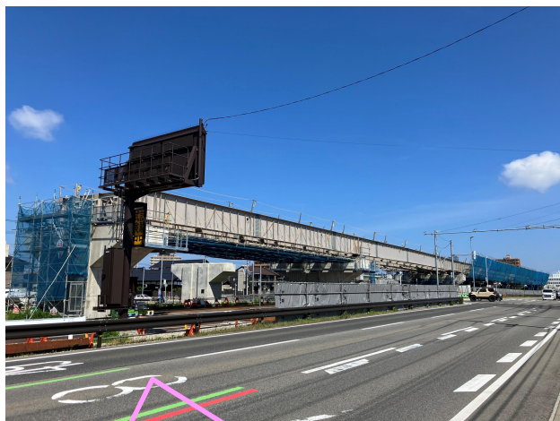
見学する鋼橋
