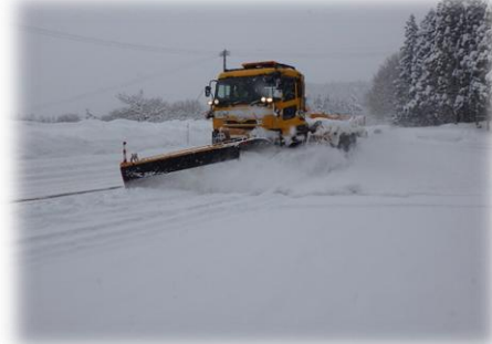
せきかわむらたかのす 国道113号関川村鷹ノ巣付近の （令和8年2月撮影） 除雪状況
