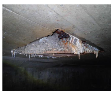
橋の裏面の様子
