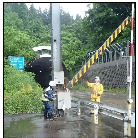
遮断機の降下作業中 (福取駐車帯)
