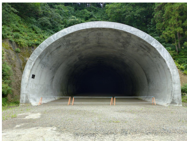
（仮称）4号トンネル 山形側坑口
