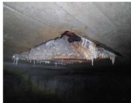
橋の裏面の様子
