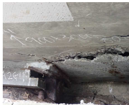
橋の裏面の様子
