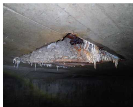
橋の裏面の様子
