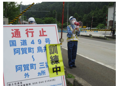
① 通行止め規制状況(津川除雪ST)
