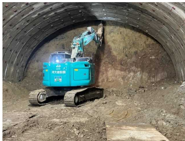
【掘削時の状況】
