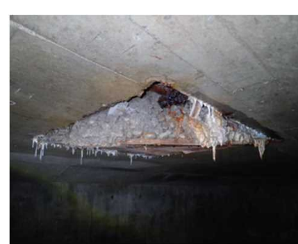
橋の裏面の様子
