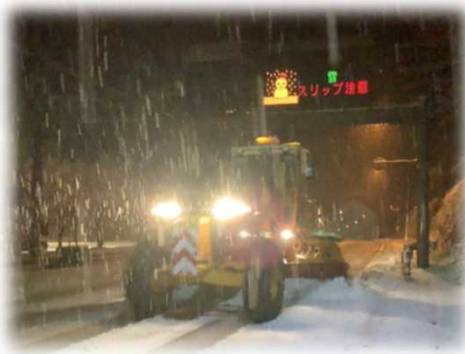
あがまち 国道49号阿賀町付近の除雪状況 (令和4年12月撮影)
