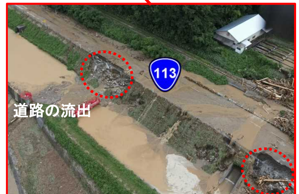
道路の流出 (R4.8.4撮影)
