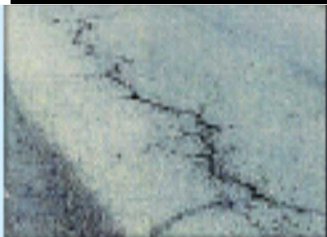
舗装のひび割れ
