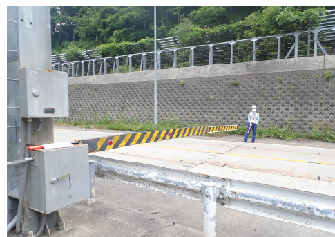
①遮断機を降下完了した状況（福取駐車帯）
