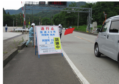
②通行止め規制状況（津川除雪ST）
